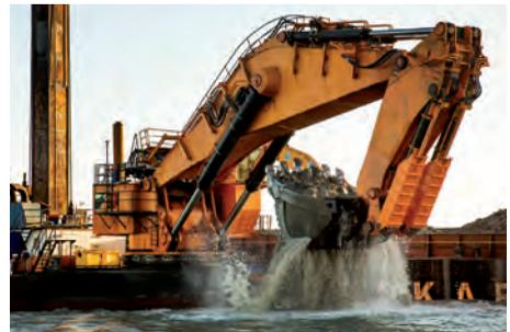
*Der Löffel des Baggers fasst 34m<sup>3</sup>, er wirbelt aber mehr Sediment auf als er fördert*
